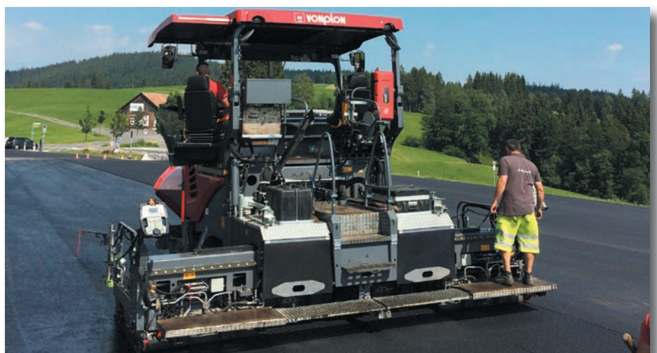
Der Belag auf dem Raten-Parkplatz wurde Ende Juni verstärkt.
