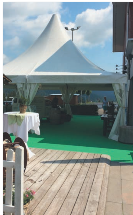
Hier entsteht ein Wintergarten.
