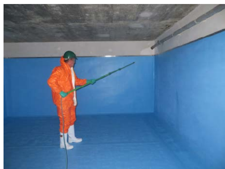
Bevor das neu beschichtete Reservoir wieder in Betrieb genommen wird, wird es desinfiziert.
