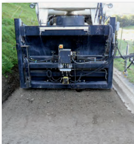
Spezialmaschine hackt den alten Strassenbelag, mischt Zement und Wasser dazu und verlegt den neuen Belag – es bleibt kein Kilo Bauschutt zurück.
