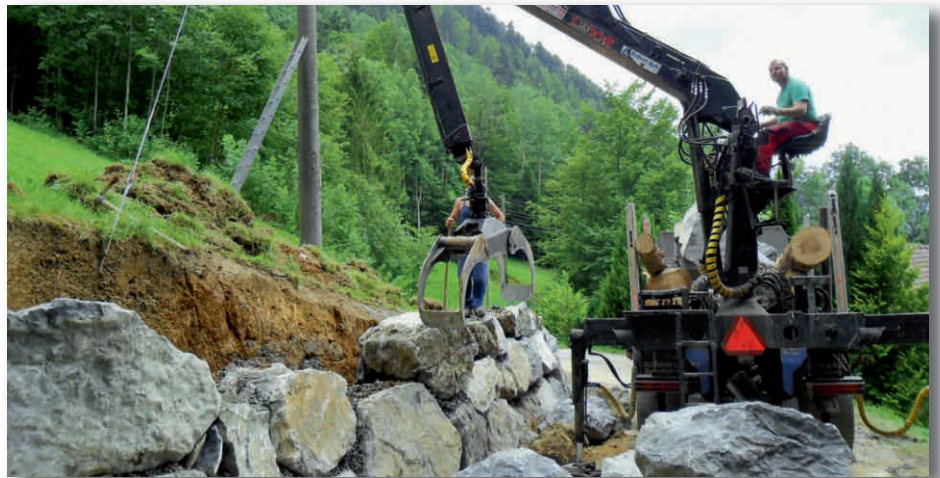
Bruchsteinmauern sichern den Hang bergseits der Strasse.
