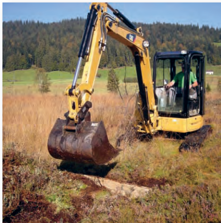
Anbringen eines Staelements in altem Entwässerungsgraben.
